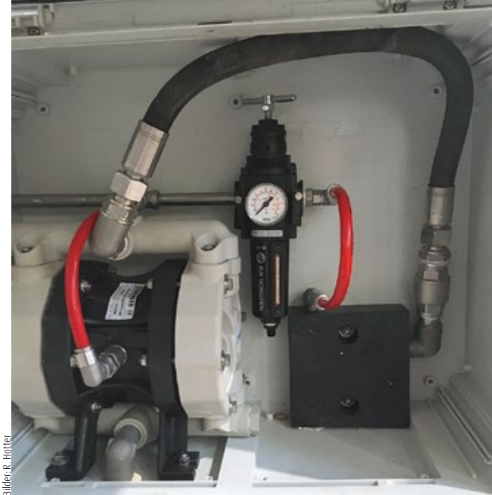
Abbildung 1: Komponenten der Schaumpumpe
